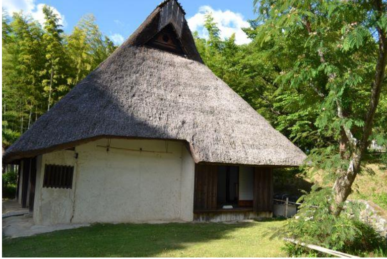
Resim 8 Yamashita Evinin ahşap duvarı sıvalıdır.
