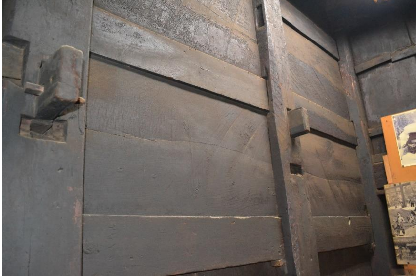
Resim 17 Oui Evi ahşap geçme teknikleri
