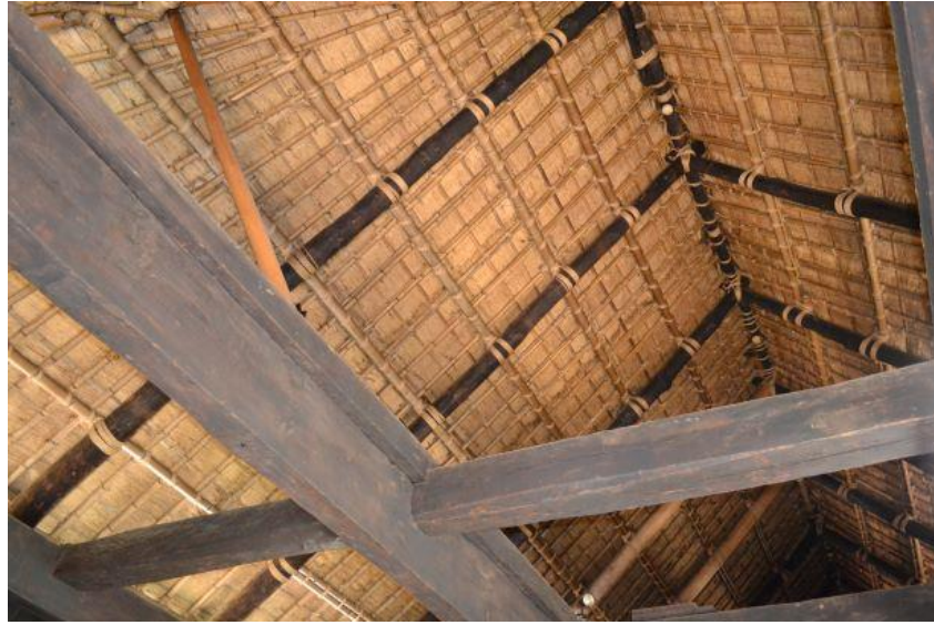
Resim 18 Shiiba Evi çatı iç görünüş bağlama teknikleri
