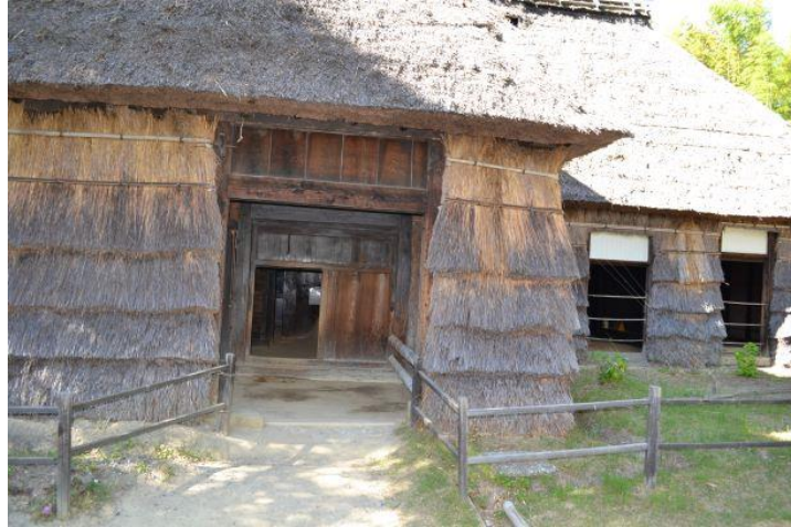
Resim 7 Yamada Evinde çatı ve duvarlar bitkisel malzeme ile kaplıdır.
