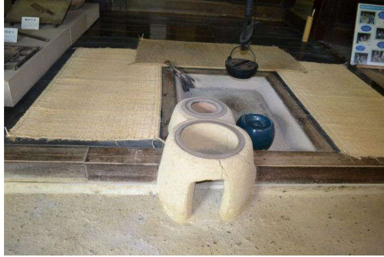
Resim 20 Yamashita Evi ısınma ve yemek pişirme ocağının bir arada olduğu örnek.
