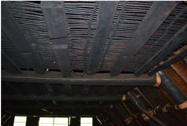
Resim 21 Isınma ve Yemek pişirme ocaklarından çıkan duman ile islenmiş tavan örtüsü.
