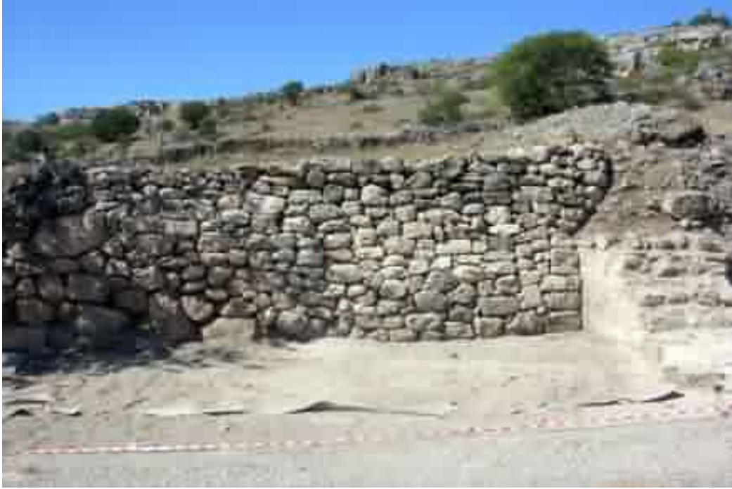
Foto. 51: Apsisli Yapı Genel Görünüm (Hadrianoupolis Kazı Arşivi)
