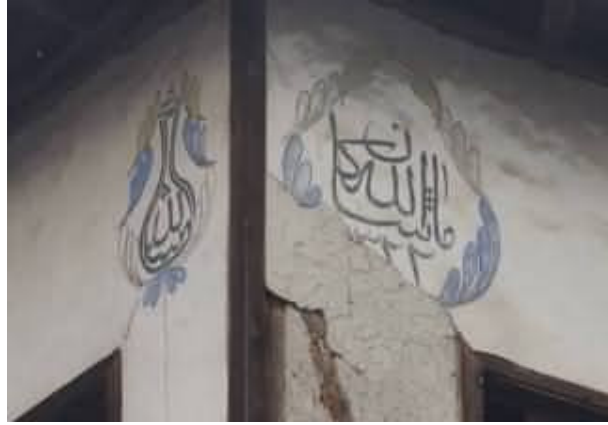
Foto. 24. Şahinler Evi. Mehmet Kurtulan Meydanı, Kayadibi Sokak, No: 2a. Saçak Altı Köşede, Gülabdan Formu İçerisinde Maşaallah (Sol)- Bitkisel Çerçeve içerisinde Maşaallah Kâne – 1322(Sağ).
