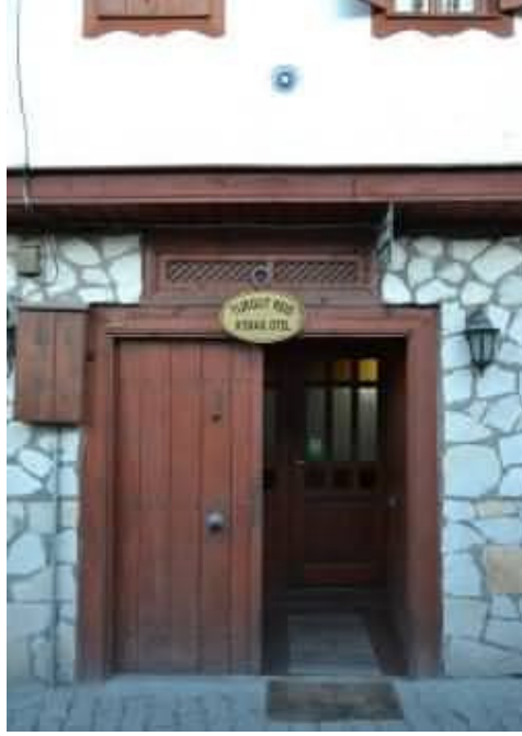
Foto. 7. Turgut Reis Konak. Karaali Mahallesi, Akpınar Sokak, No:27. Giriş cephesi At nalı Nazarlık ve Cam nazarlık
