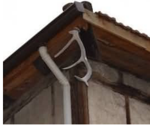
Foto. 50. Hacı Halil Mahallesi, Gümüş Sokak, No:22. Saçak Altı Köşede Asılı Geyik Boynuzu.
