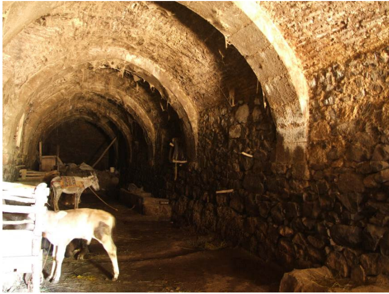
Foto 10: Yukarı Yongalı Çengilli Kilisesi II Nolu Güneybatı Yapısı
