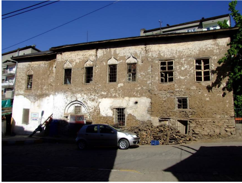
Foto 4: Hakim Erden Evi Batı Cephe
