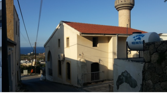
Şekil 17: Caminin arka cephesi (güney) (Eyyamoğlu,2018)
