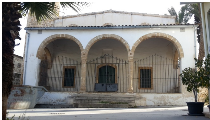
Şekil 13: Caminin ön cephesi (Eyyamoğlu, 2018)
