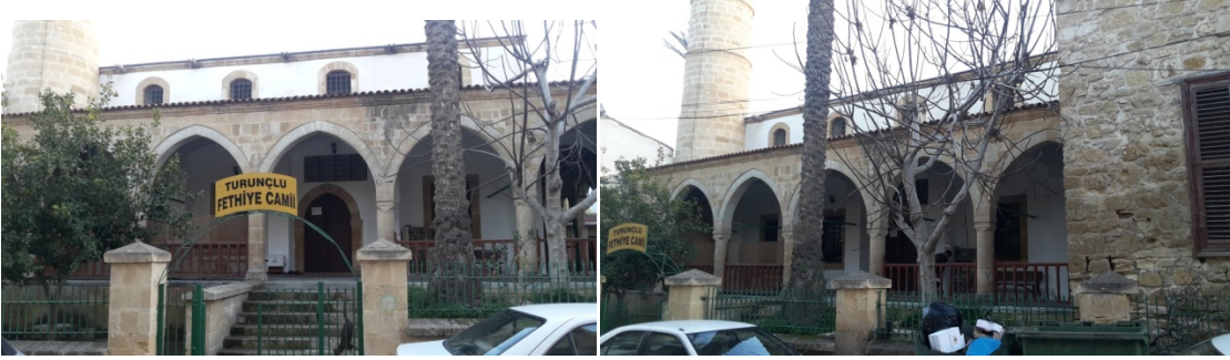
Şekil 7&8: Fethiye camii kuzey cephesi (ana giriş) (Eyyamoğlu, 2018)
