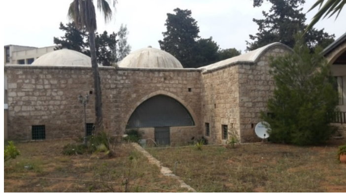
Şekil 20: Türbe binalarının avludan görünümü (kuzey) (Eyyamoğlu, 2016)
