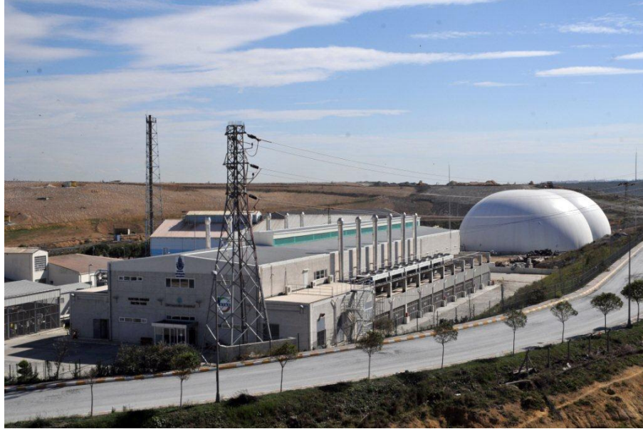
Şekil 1: Odayeri enerji üretim tesisi genel görünümü
